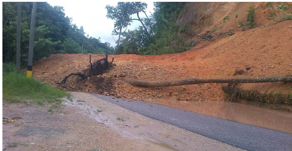
La carretera que se dirige a Copán Ruinas quedó interrumpida luego de un deslizamiento de tierra y lodo.
