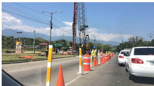
Las obras comenzaron un domingo de febrero.
