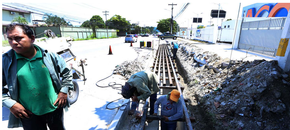
Canales pluviales como estos evitará que la Segunda Calle se inunde en época de lluvia.
