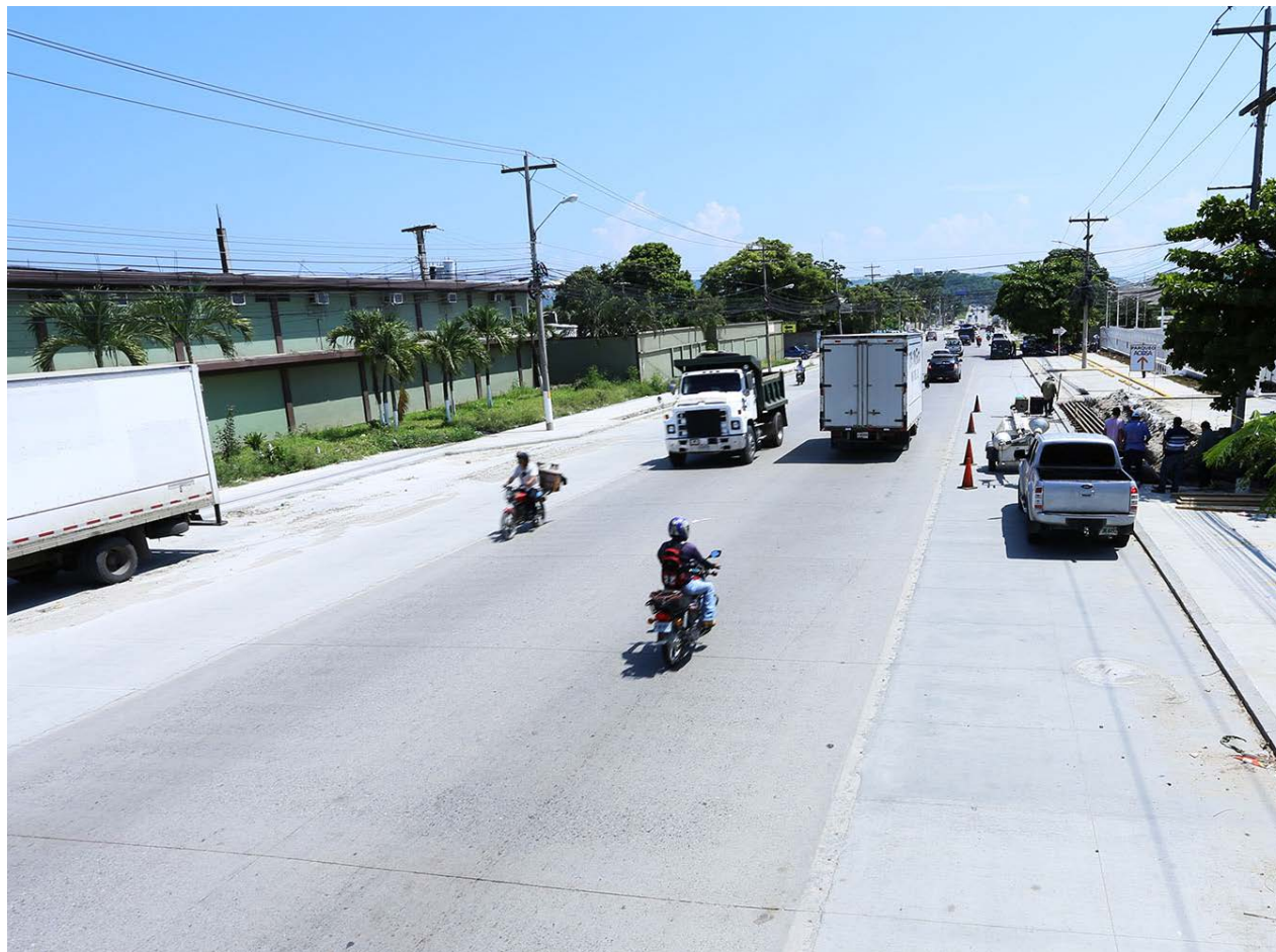
Así está quedando la Segunda Calle o más conocida como calle Salida a La Lima.
